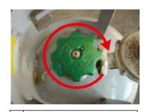
消火したことを確認して、プロパンガスの元栓を完全に閉めます。
